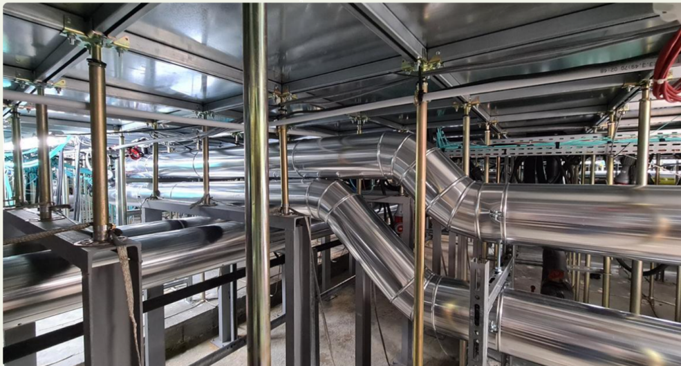
Figure 27 : Tuyaux du système de refroidissement du supercalculateur Jean Zay Source : CNRS, 2024 80 . © Rafael MEDEIROS / IDRIS / CNRS Images
