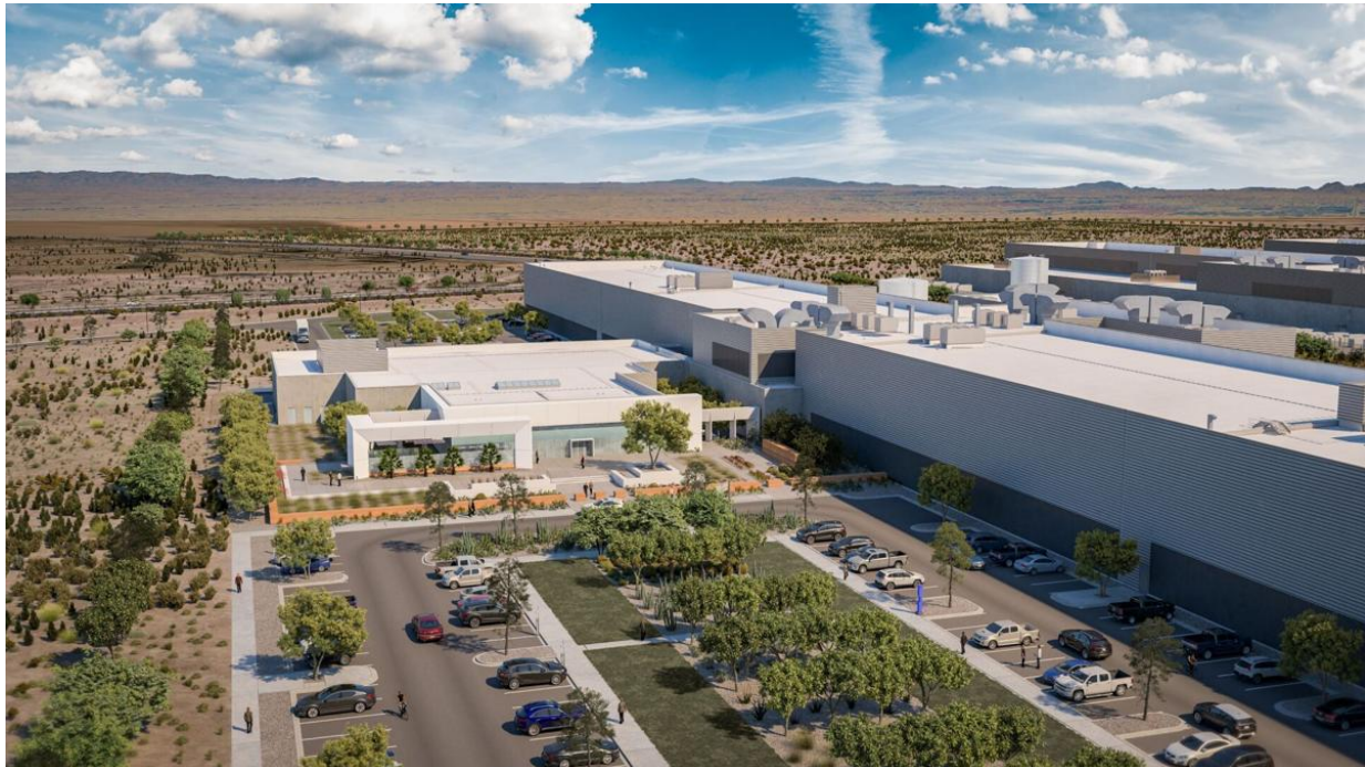
Figure 25 : Data center de Meta à Mesa (Arizona). Un cluster distinct est en projet à Tucson.
